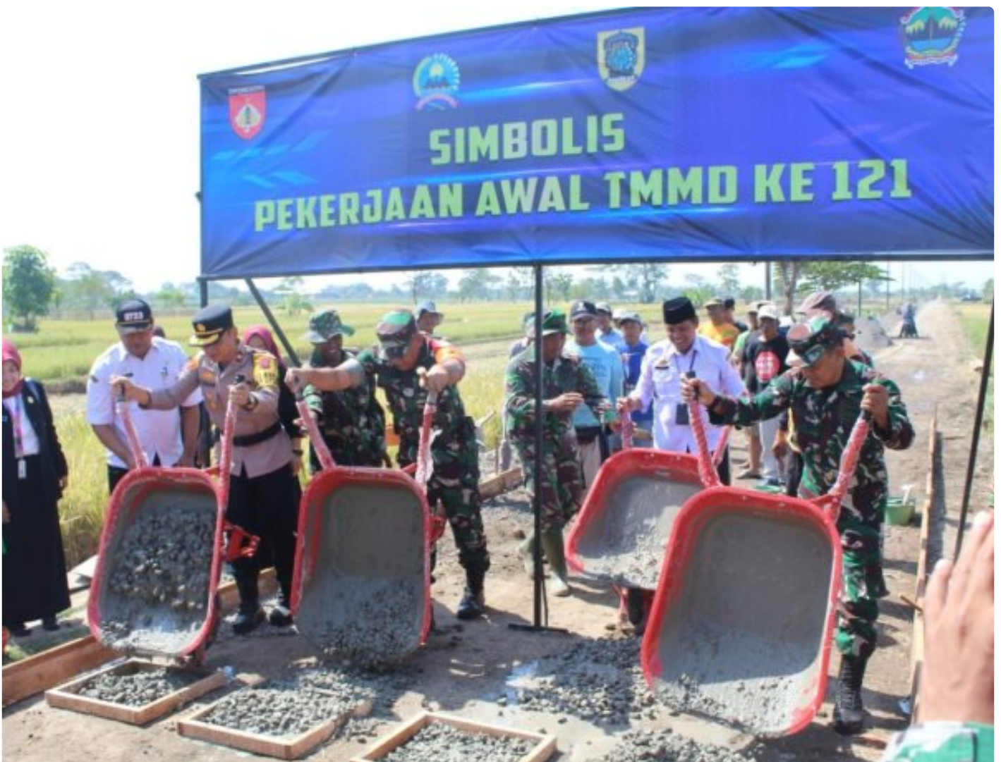
Pengecoran Perdana TMMD Reg 121 dilakukan Forkopimda Klaten
