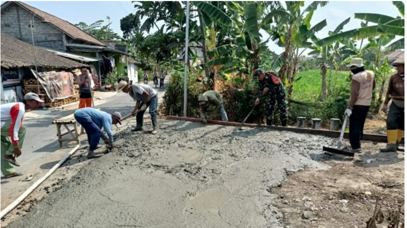
Kemanunggalan TNI Bersama Rakyat, Babinsa Koramil Klaten Utara Gotong Royong Pengecoran Jalan
